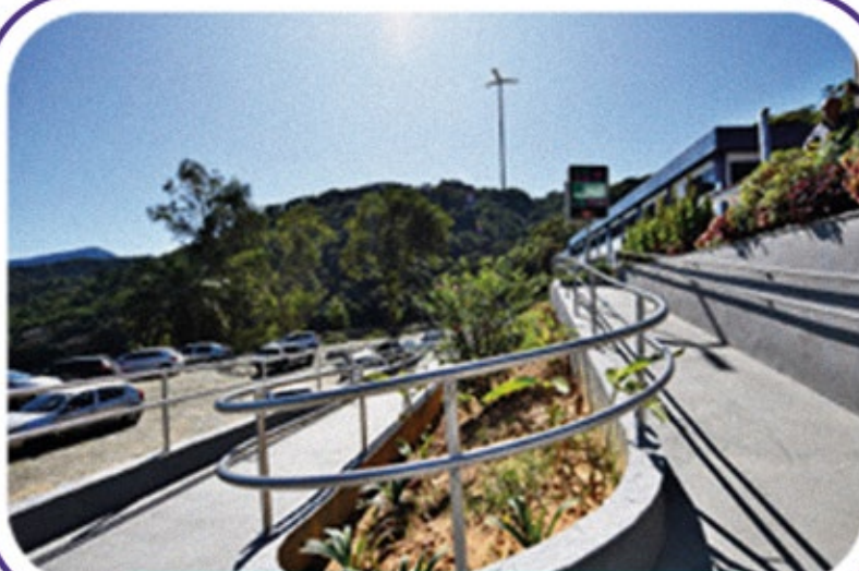
Rampa de acesso – campus Quinta do Paraíso
